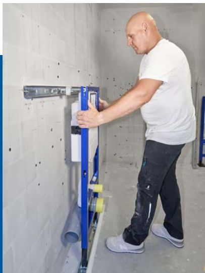
Régis Heitzler otáča nástennú kotvu o štvrtinu otočky nahor – úplne bez použitia náradia.
